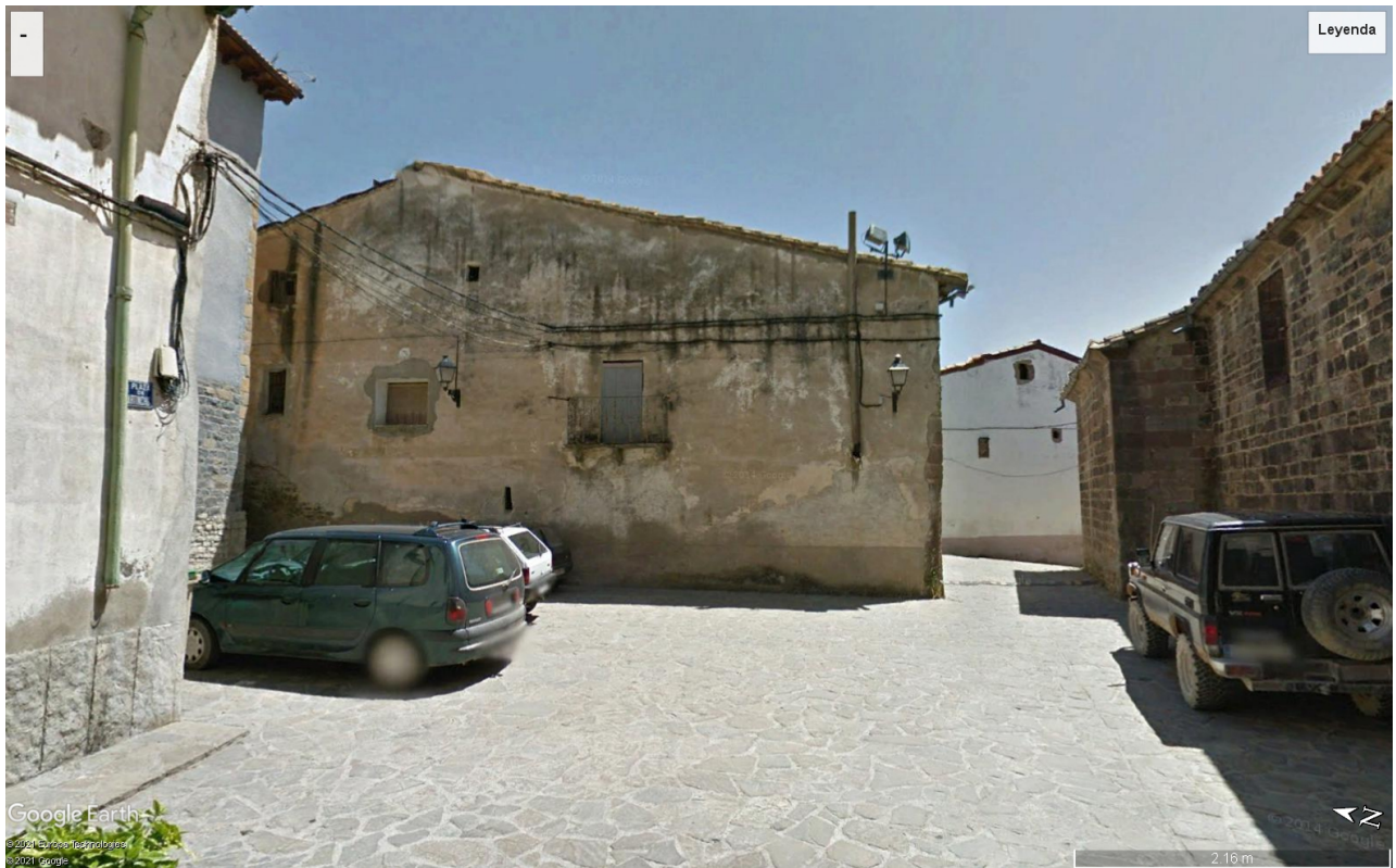
Vista general actual desde la Plaza Martincho y su entorno.
